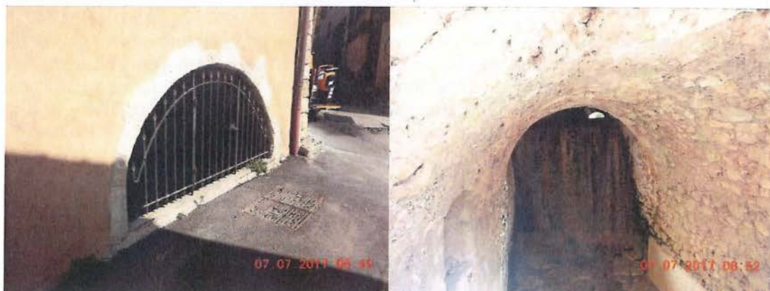
Passage du Riou Blanquet sous une habitation
