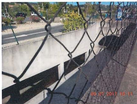
Ouvrage galerie sous le Riou Blanquet
