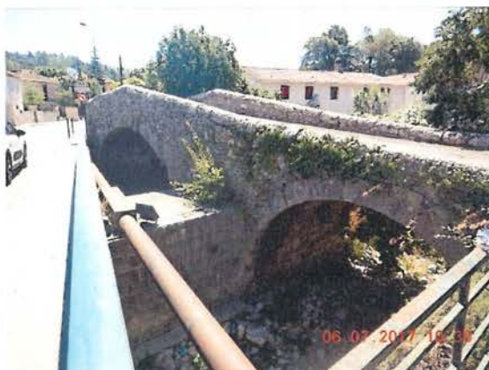
Pont double arche sur le Grand Vallon
