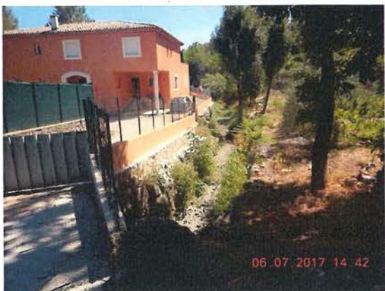
Vallon Saint Antoine à proximité d'une habitation
