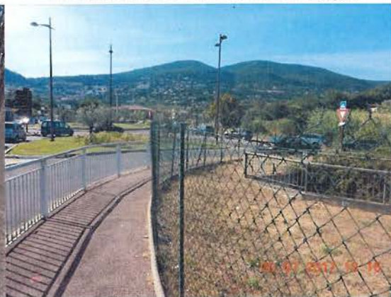
Passage du Riou Blanquet sous un giratoire
